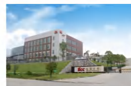
■ 实创科技厂区图一
