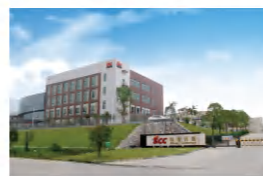
■ 实创科技厂区图一
