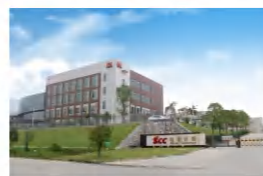
■ 实创科技厂区图一
