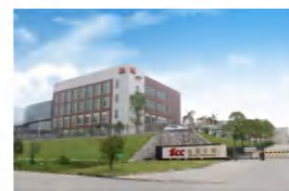
■ 实创科技厂区图一
