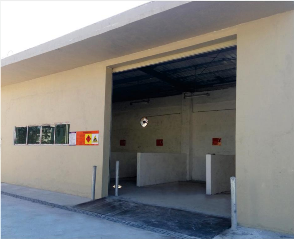
固体废物贮存场所
